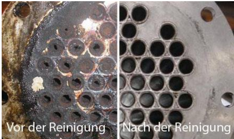
Reinigung eines Ölkühlers
