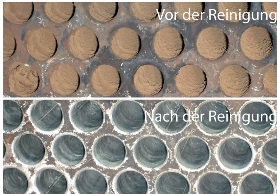
Reinigung von Kesselrohren
