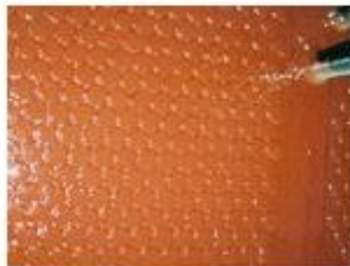
Schritt 5: Applikation Voranstrich mit Plastocor® - PT prime-coat
