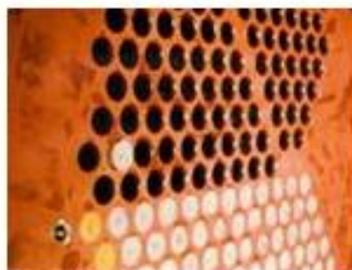
Schritt 8: Entfernen der Spachtelstopfen
