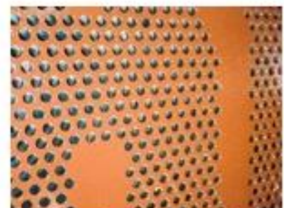
Schritt 9: Fertiger Rohrboden versiegelt mit Plastocor® - PT topcoat
