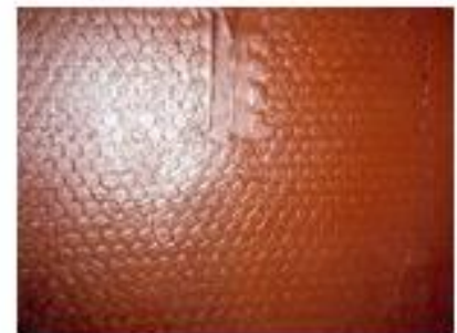
Schritt 6: Gespachtelter Rohrboden mit Plastocor® - 2000
