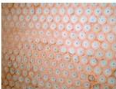
Schritt 7: Geschliffener Rohrboden
